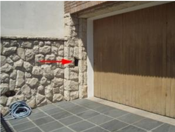
Barrera en planta baja embutida entre ladrillos.
